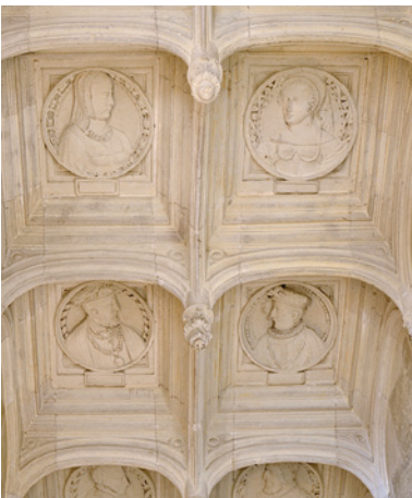
Techo de la escalera de honor.
