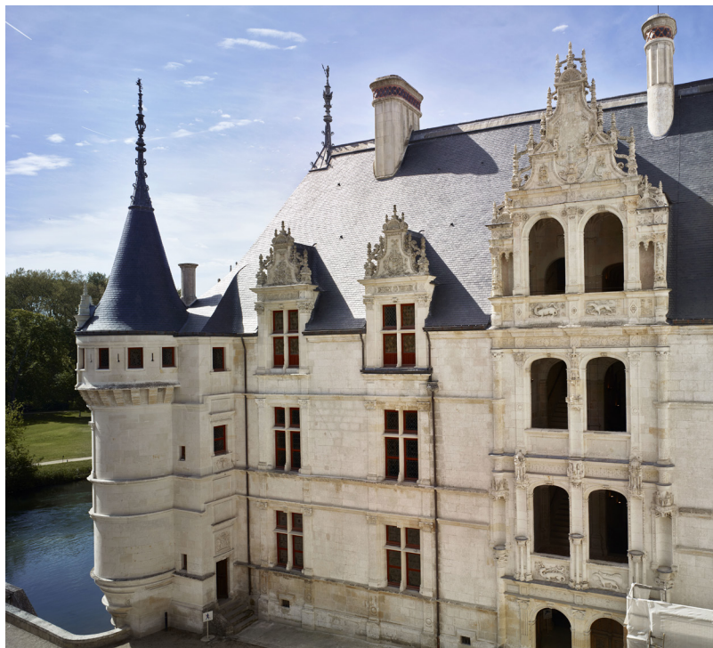
Château d'Azay-le-Rideau, façade nord dite de l'escalier © Thomas Jorion - Centre des monuments nationaux
