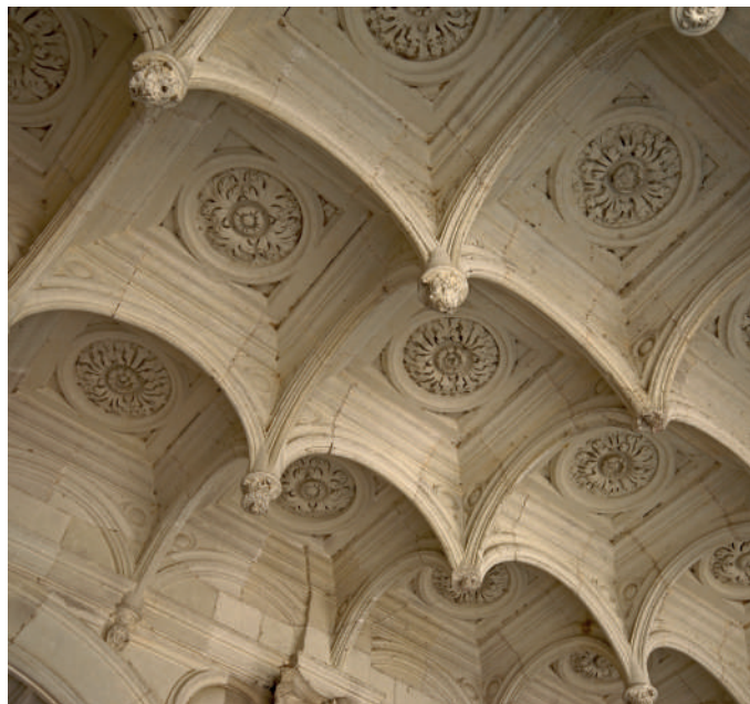
Plafond à caissons du premier repos de l'escalier © Philippe Berthé
