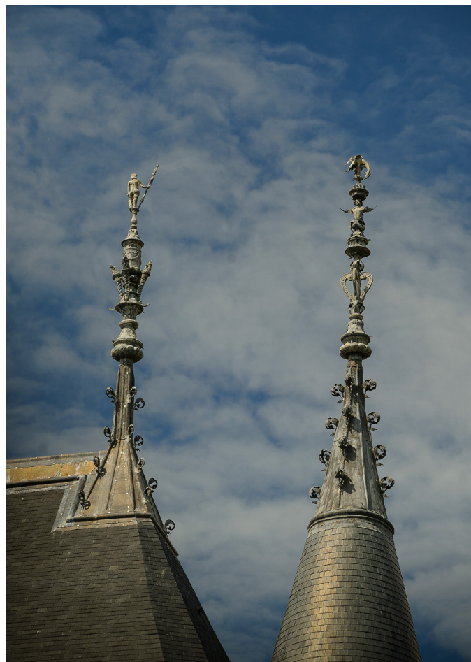
Détail du toit © Léonard de Serres
