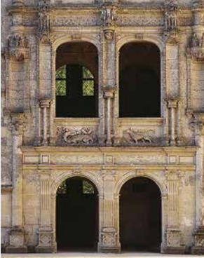
> Façade de l'escalier
