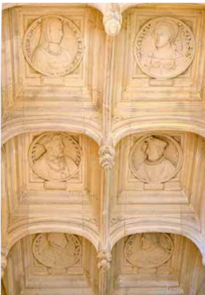
> Plafond à caissons du grand escalier
